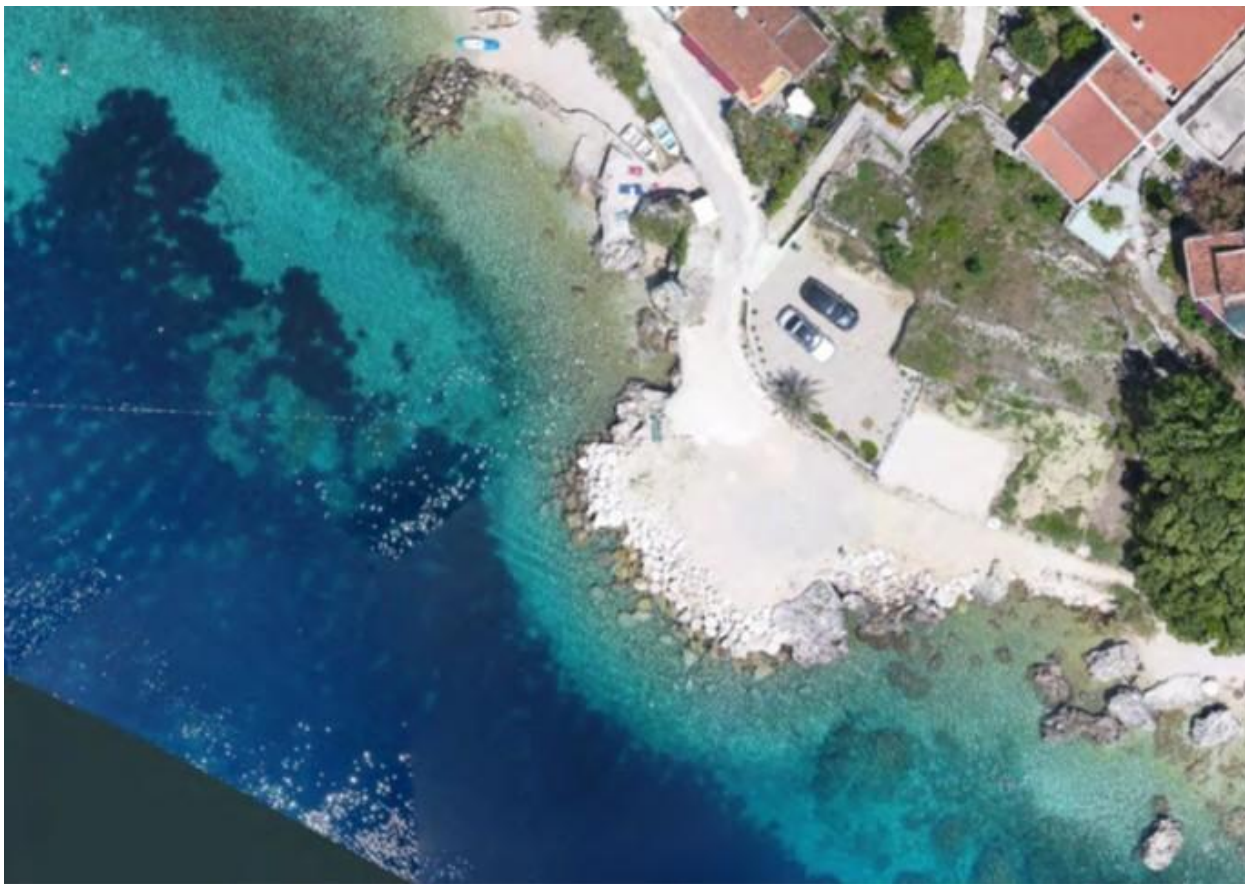
Slika 1. 1 - 1 Snimak postojećeg kamenog nasipa iz zraka (Izvor: Idejno rješenje)
